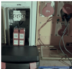
Schleifenimpedanzmessung an einem Baustromverteiler mit CEE 16 Adapter
